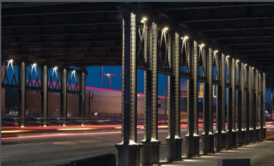
Viaduc SNCF Lyon Perrache Lighting design: Direction de l'Éclairage Public de la Ville de Lyon Photo: Michel Djaoui
